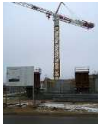
Le futur immeuble sort de terre.
